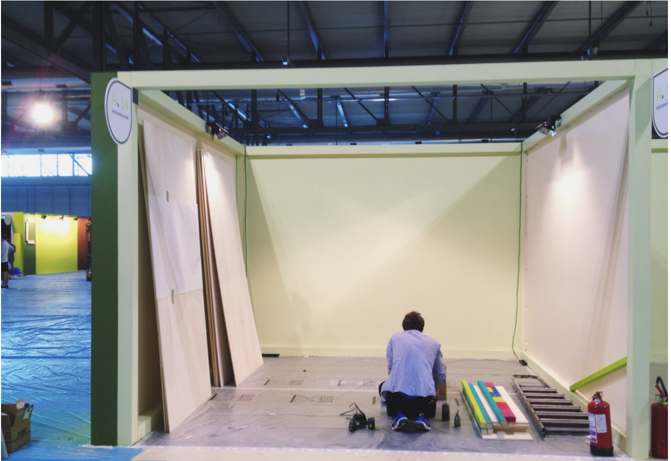
Figur 118. Materialene på plass i Milano. Platene ble fraktet i 18 deler. Seks plater trengte tilkapping på stand, for å få plass.
