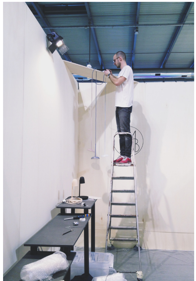
Figur 120. Montering og plassering av produkter. Foto: Alexander Åsgård
