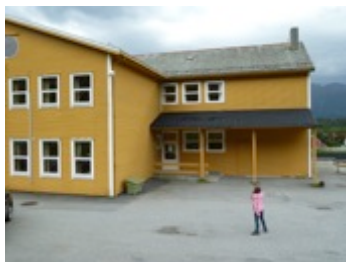
Elevane sine visuelle undersøkingar.
