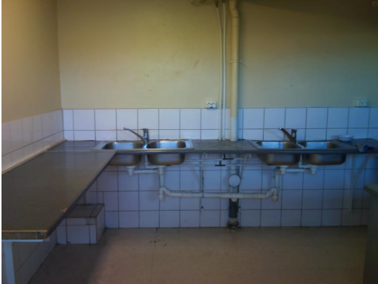
Bilde nr. 3 (over): Kjøkkenet i bygning nr. 2
